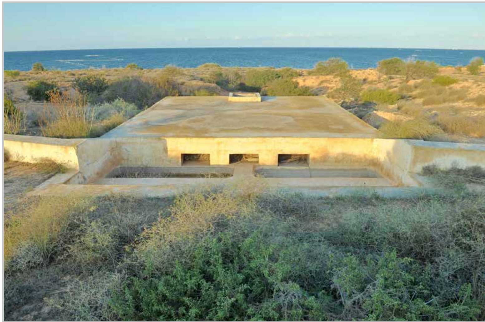
Petit ouvrage hydraulique abandonné dans l'archipel kerkenien
