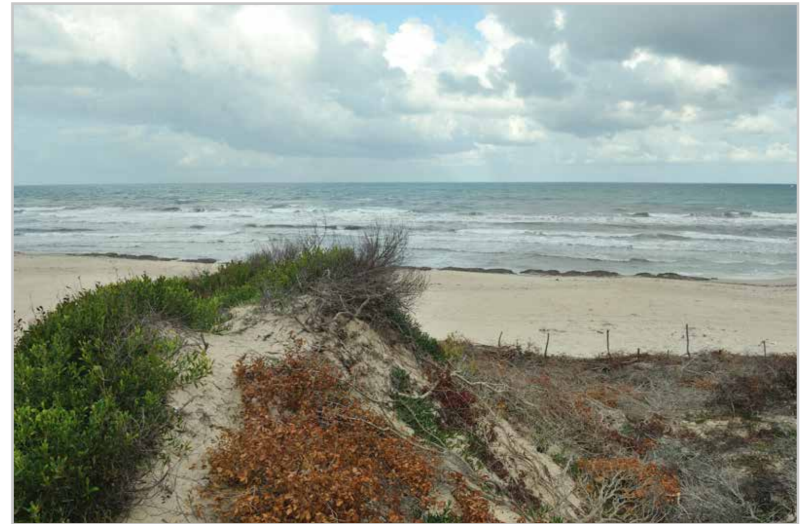
Par des branchages appliqués aux surfaces sableuses (Côte de Zoggag, Cap Bon)
