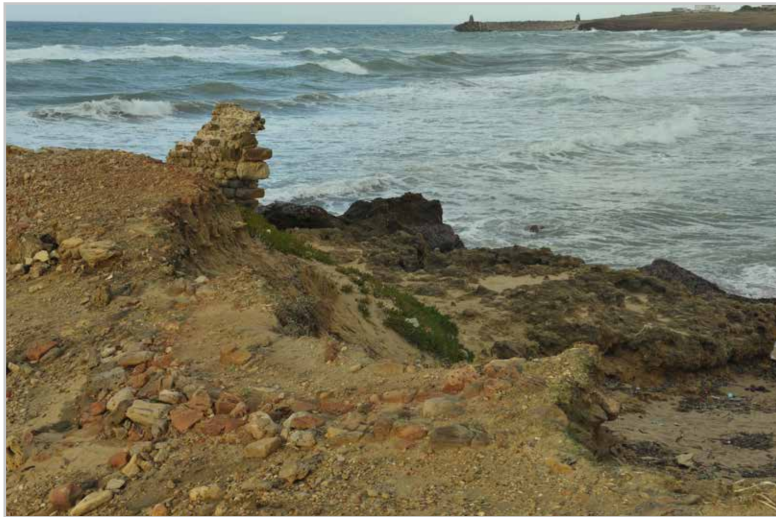
Pourtant, bien des situations indiquent que la mer est décidée à gagner du terrain (four à chaux antique sectionné par le recul d'une petite falaise à Sidi Mechrig)
